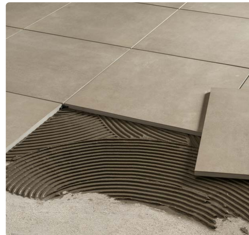
Posa su massetto con colla - Laying on screed with adhesive Traditionelle Verlegung auf Estrich - Pose à la colle sur dalle
